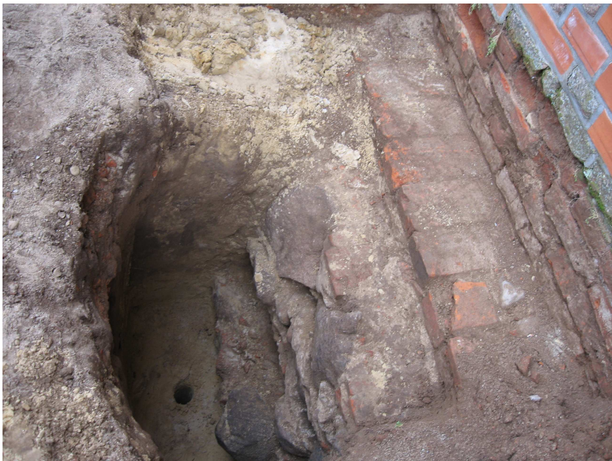
Fot. 7. Widok odkrywki fundamentowej nr II - od strony zachodniej kościoła ;
