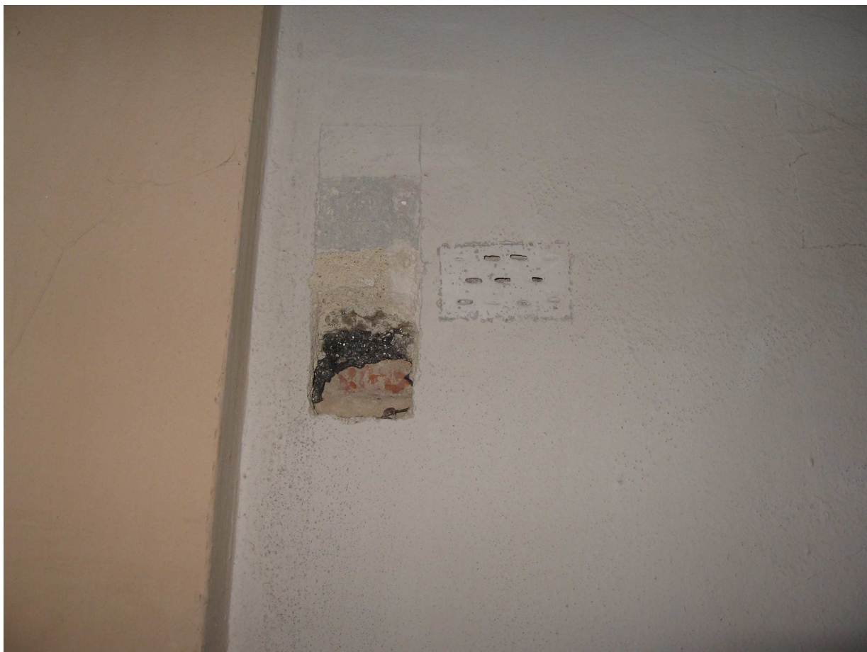
Fot. 5. Widok odkrywki muru od wnętrza kościoła ( widoczna papa pod tynkiem ) ;
