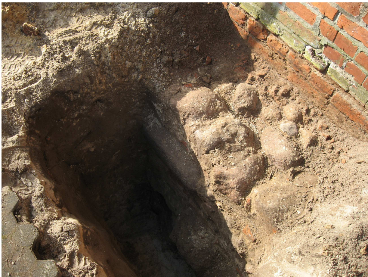
Fot. 6. Widok odkrywki fundamentowej nr I - od strony wschodniej kościoła ;
