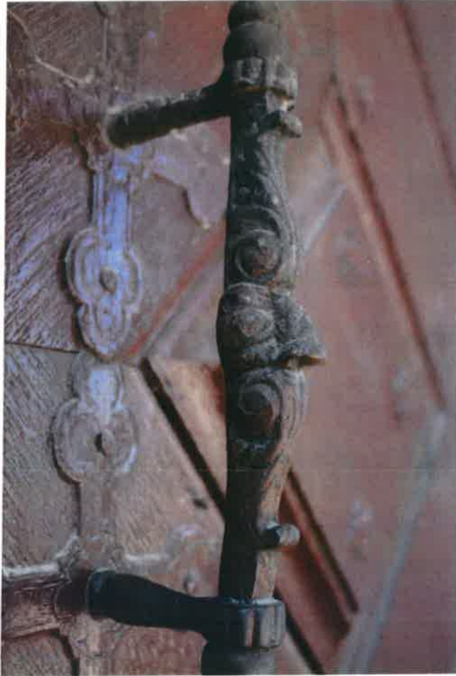
Fot. Drzwi do kościoła
