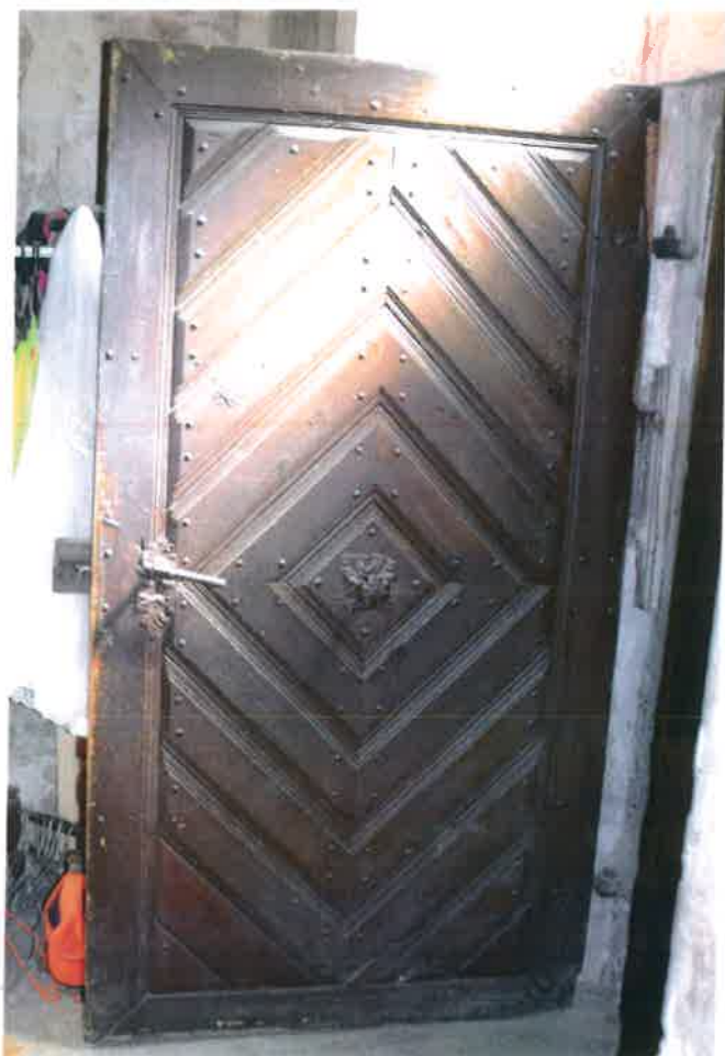
Fot . Drzwi do zakrystii
